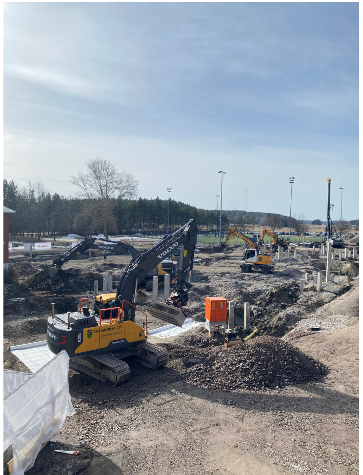
Maanrakennustyöt ja paalujen katkaisu käynnissä
