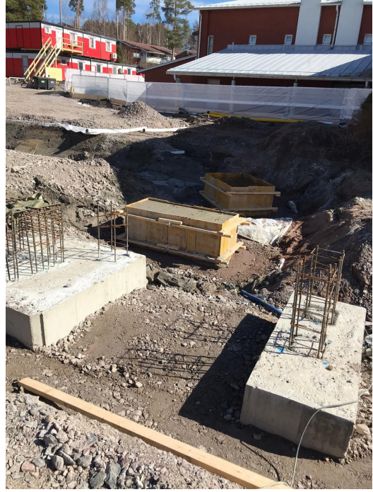
Valettuja ja vielä muotissa olevia paaluanturoita.
