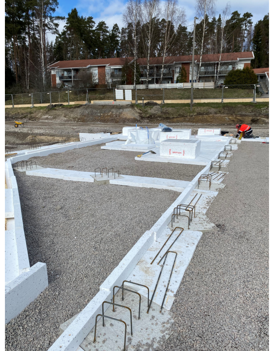
Väestönsuojan lattian pohjatyöt käynnissä.
