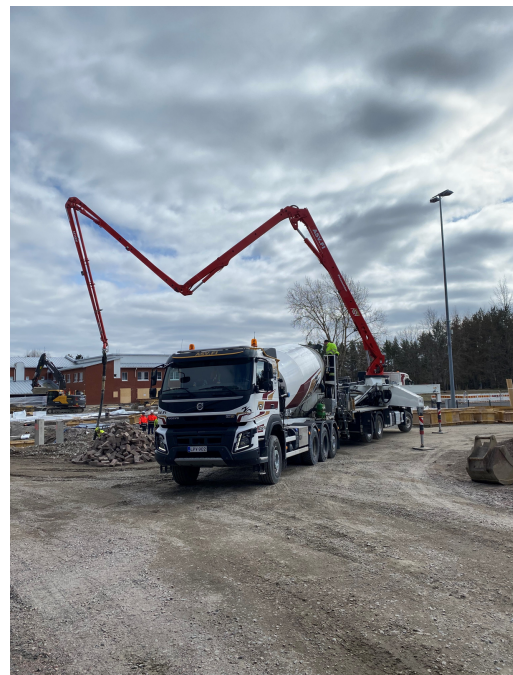
Betonivalutyöt käynnissä.
