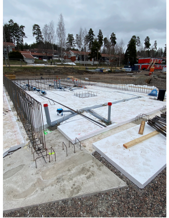
Väestönsuojan lattian viemäröinti-, raudoitus- ja eristystyöt käynnissä.
