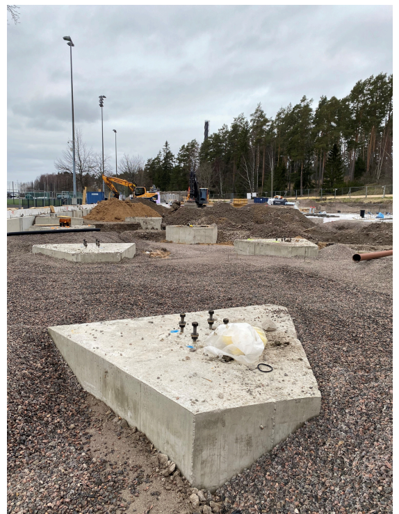
Maantasaustyöt rakennuksen sisäpuolella käynnissä.
