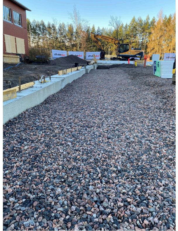
Sisäpuolinen täyttötyö käynnissä.
