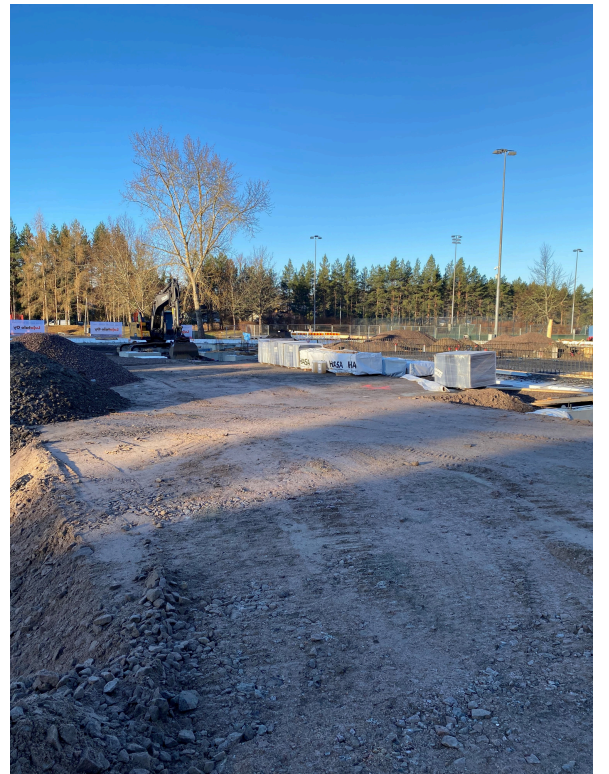
Elementtiasennuksia varten ajoneuvonosturille tehdään tukeva alusta.
