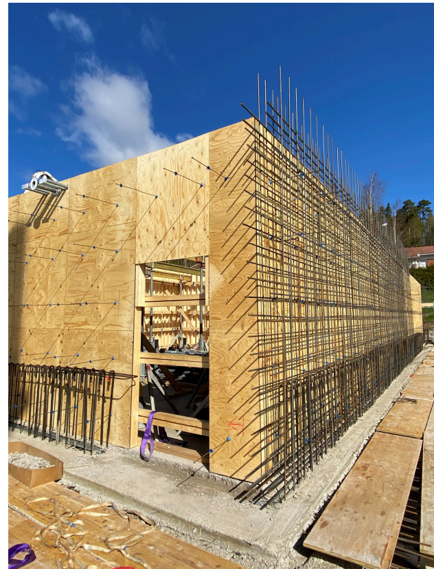
Väestönsuojan rakennustyöt käynnissä.
