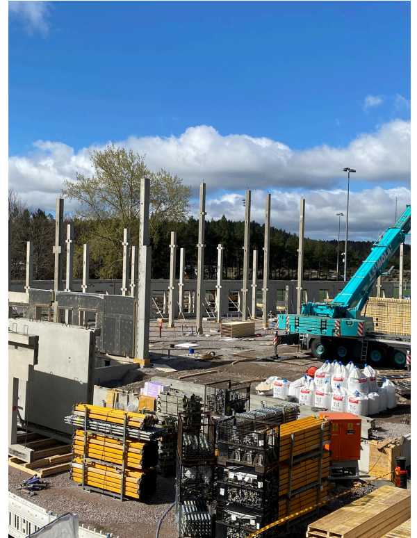
Betonielementtiasennukset aloitettu.
