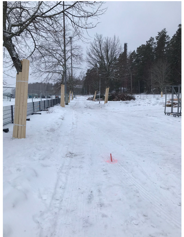
Kuva: Säilytettävää puustoa suojattu
