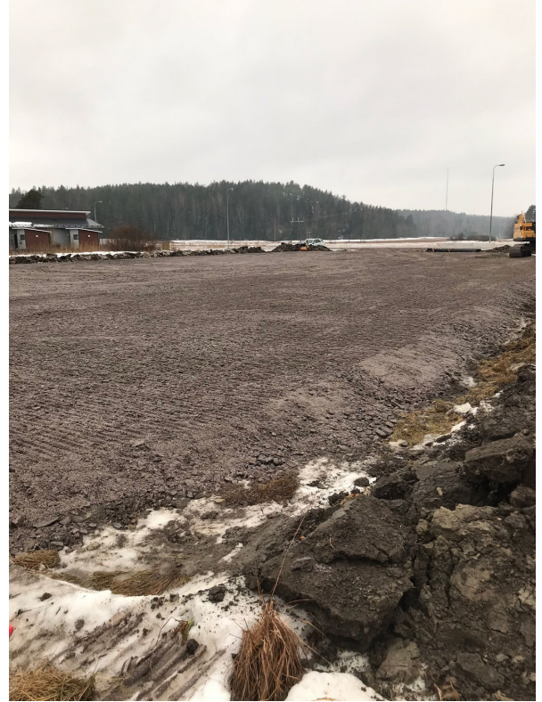
Kuva: Rakenteilla oleva työmaan henkilöstön parkkipaikka
