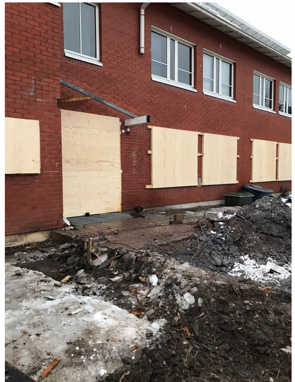
Kuva: Työmaa-alueen alimman kerroksen ikkunat suojattu
