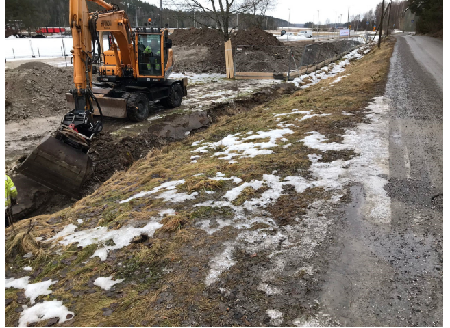
Kuva: Työmaan ajoliittymän kaivaminen
